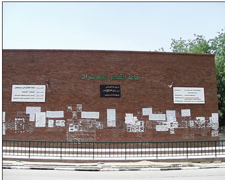
Figure 2 : salle de conférence construite par la Libye dans l'université de Khartoum
