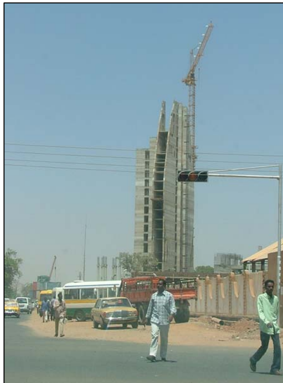
Figure 1 : Immeuble libyen en construction dans le centre de Khartoum
